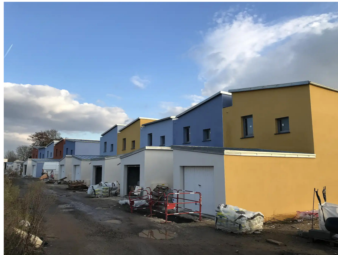
Photos du chantier
