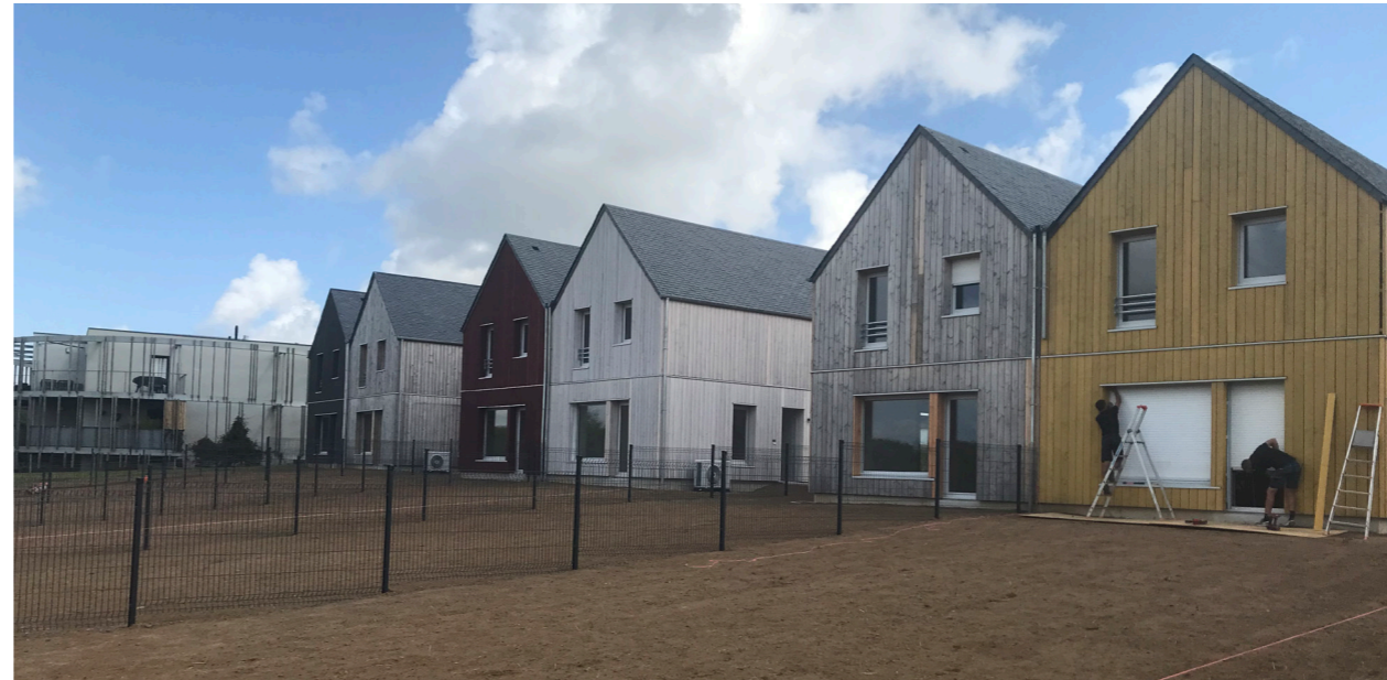
Photo de chantier
